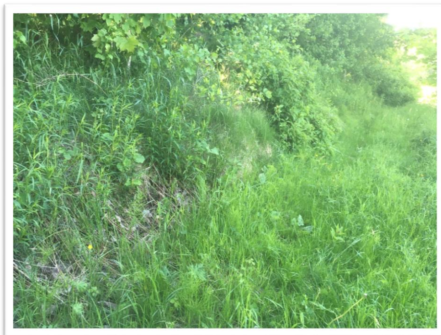
Photographie 2 : Vue de la faible encoche d'érosion à la rencontre du pied de talus et de la terrasse.
